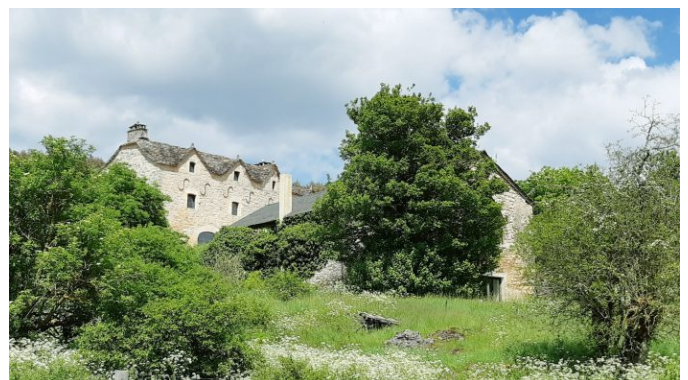
vue générale côté sud
